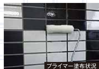
プライマー塗布状況
