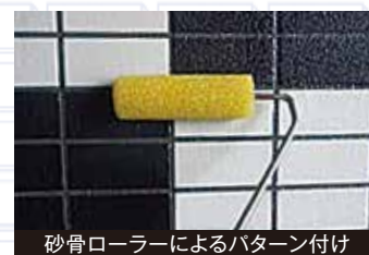
砂骨ローラーによるパターン付け
