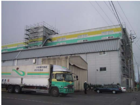
倉庫(押出成型パネル)
