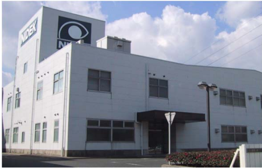
工場(ALCパネル) (施工後15年経過)
